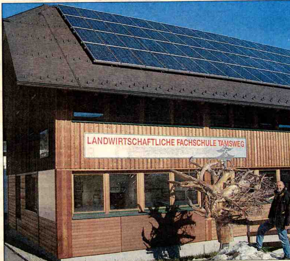
Das Sonnenenergie Dach der Landwirtschaftlichen Fachschule Tamsweg liefert Strom für das öffentliche Netz. Im Bild DI Walter Breustedt, ein aus Deutschland stammender Energieexperte, der auch im neuseeländischen Auckland lebt und Pionierarbeit für die dortige Regierung leistet.
