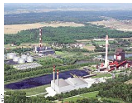
In Mellach entsteht ein neues Gaskraftwerk
