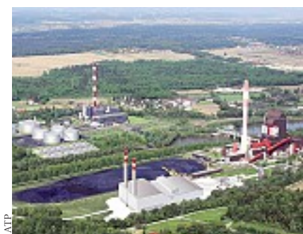
In Mellach entsteht ein neues Gaskraftwerk
