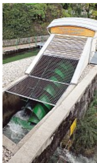
Wasserschnecke: Braucht wenig Platz und kaum Wartung
